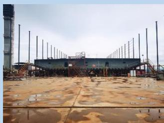
2021年8月，公司首次制作和安装大跨度钢箱梁栓焊组合结构的双塔单跨钢箱梁悬索桥——江底河特大桥项目进入现场组装阶段，该项目的顺利推进标志着公司大跨度栓焊组合钢箱梁桥制造技术取得阶段性成果。
